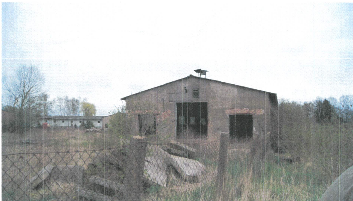
Bild 03 Großer Stall vom Westen im Norden Verwaltungsgebäude
