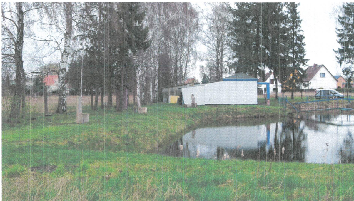
Bild 11 Regenrückhaltebecken im Osten außerhalb des UG
