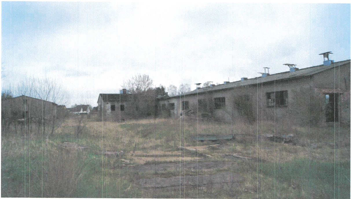
Bild 08 Stall und Verwaltungsgebäude vom Nordosten
